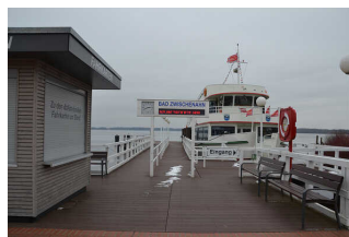
Anleger Bad Zwischenahn
