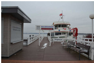
Anleger Bad Zwischenahn
